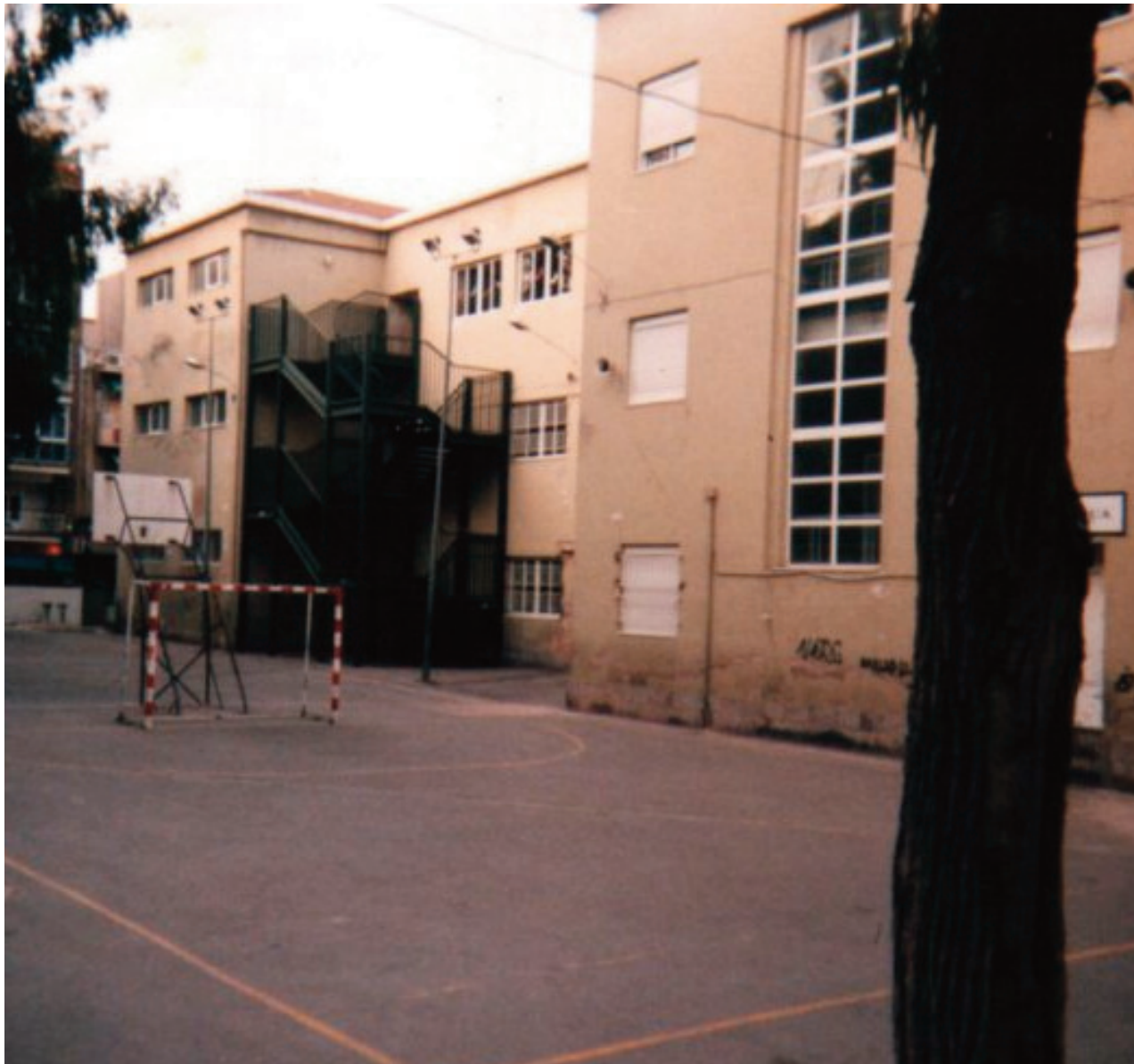
El antiguo colegio Benalúa sufría el deterioro propio de un edificio construido en la República / Barriodebenalúa
